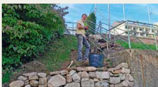
Unter der Anleitung von Dr. Thomas Kröck wurde eine Trockenmauer angelegt.
